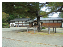
東照宮・社務所・客殿・内神殿7内神殿 社務所全景
